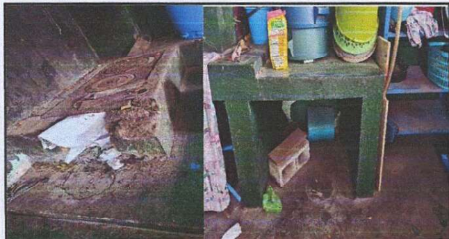
Sustitución de estufa rural, meson de cocina, sustitución de mueble y piso de cemento por piso de granito
