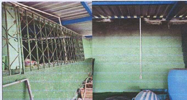
Mantenimiento y reparación de balcones y sustitución de interruptores, toma corrientes y plafoneras
