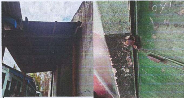
sustituciones de lamina acanalada por lamina troquela y estructura portante de metal, mantenimiento a puertas y cambio de chapas por chapas yale
