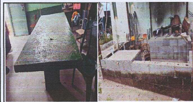
sustitución de piso de cemento por azulejo en mesa central de concreto en la cocina y pintura en muros interiores y exteriores
